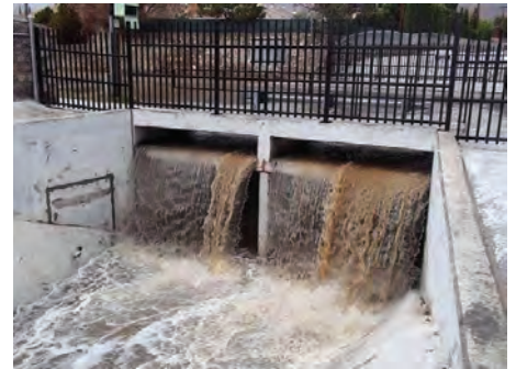
El Paso storm water project, El Paso, TX Image: El Paso Water
